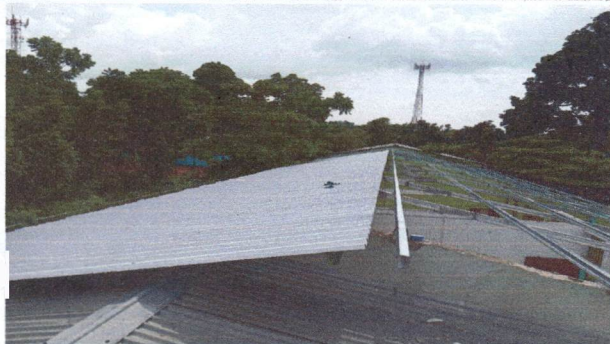
Foto 7: Se puede observar como se inicia con la instalación del techo, es decir la lamina nueva.
