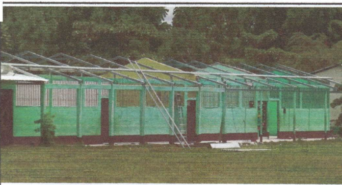
Foto 5: Inicio de las primera costaneras para instalar la lamina como parte del nuevo techo.
