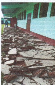
Foto 8: Se inicia con el proceso de desinstalación del piso antiguo el cual será sustituido. También se observa la instalación de la electro malla como parte del nuevo piso.
