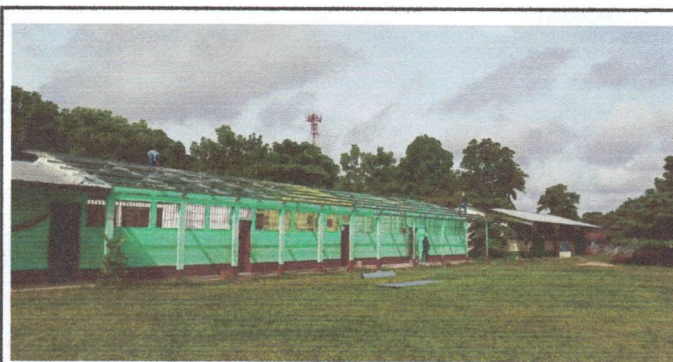
Foto 6: Culminando la colocación de las costaneras para luego instalar la lamina.
