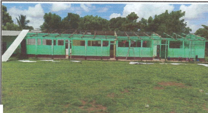
Foto 1: En esta imagen se observa el día en que fue desinstalada el techo antiguo
