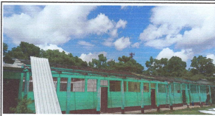
Foto 2: Este fue el momento en que se observa las desinstalacion del techo
