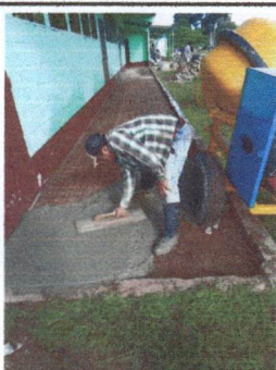
Foto 9: Durante la sustitución del piso, acá se ve como se instala el nuevo concreto como parte del piso.
