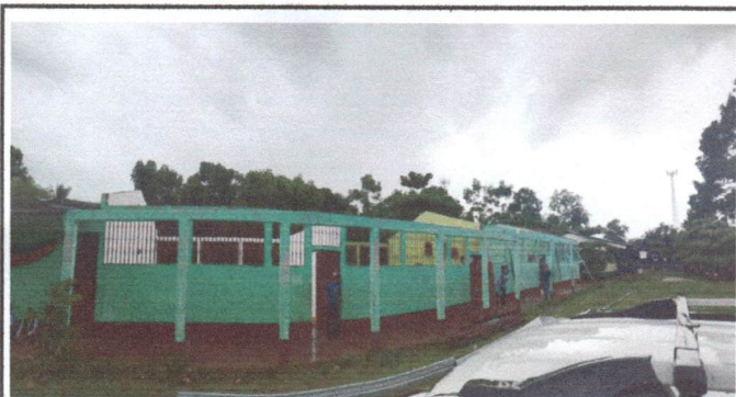
Foto 3: Aquí se observa la desinstalación del techo y de la estructura que era de madera. Preparando el espacio para instalar la nueva estructura.
