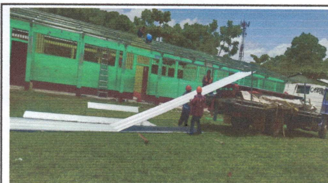
Foto 4: Ya se observa los primeros avances en la instación de la estructura metalica para colocar el nuevo techo.
