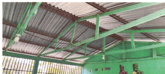
Foto: 6 Sustitución de lamina, por lamina troquelada aluzinc calibre 26
