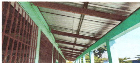
Foto 2 Sustitución de estructura de soporte de madera, por metal
