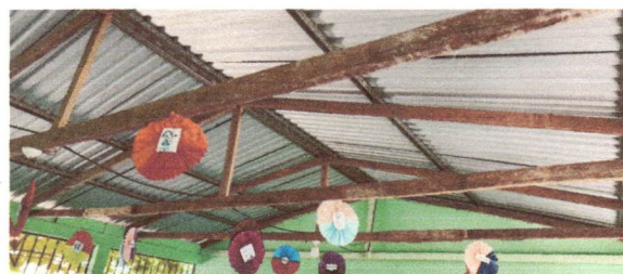
Foto: 5Sustitución de lamina, por lamina troquelada aluzinc calibre 26
