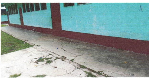
Foto 1: Sustitución de piso de torta de concreto
