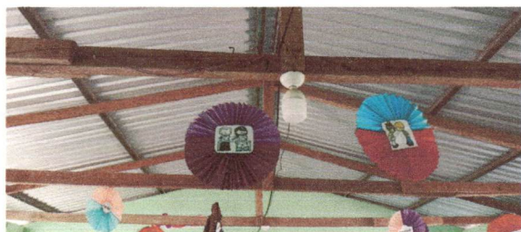
Foto 3 Sustitución de estructura de soporte de madera, por metal
