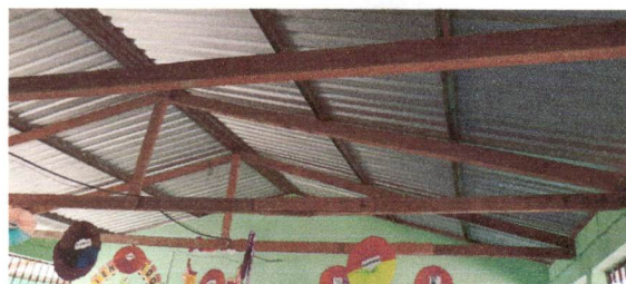
Foto 4 Sustitución de estructura de soporte de madera, por metal
