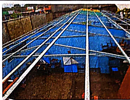
Foto 2: Sustitución de estructura portante
