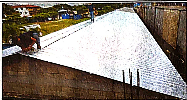
Foto1:Sustitución de lámina
