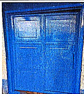
Foto 3: : Sustitución de puertas
