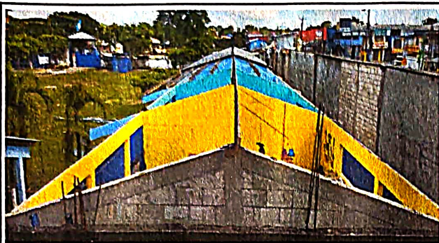
Foto1:Sustitución de lámina
