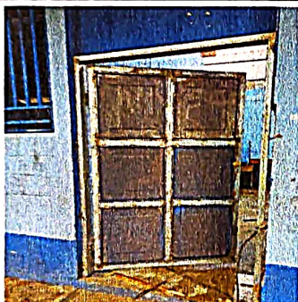
Foto 3: : Sustitución de puertas
