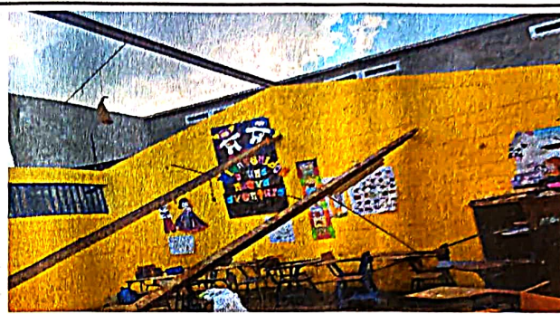
Foto 2: Sustitución de estructura portante
