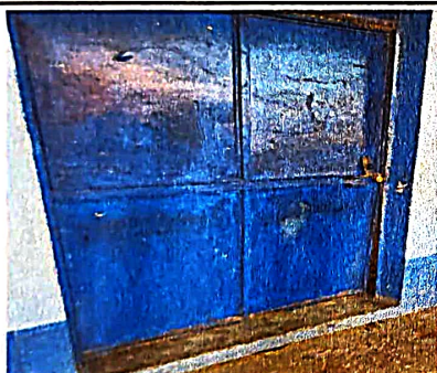
Foto 3: : Sustitución de puertas
