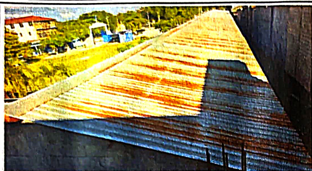
Foto1:Sustitución de lámina
