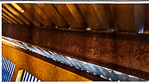
Foto 2: Sustitución de estructura portante
