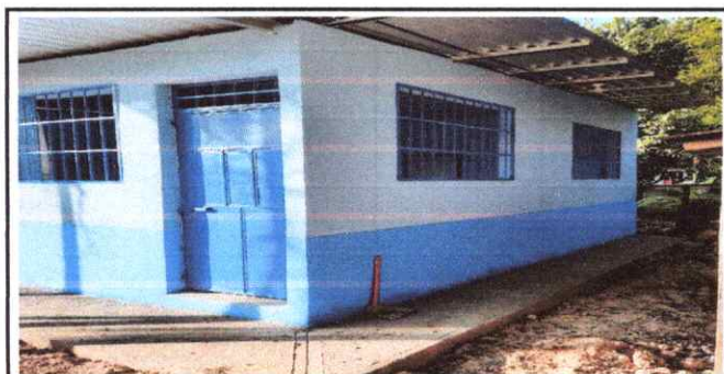
Foto 5: CERNIDO EN MUROS, SELLADOS EN GRIETAS Y FISURAS EN MUROS
