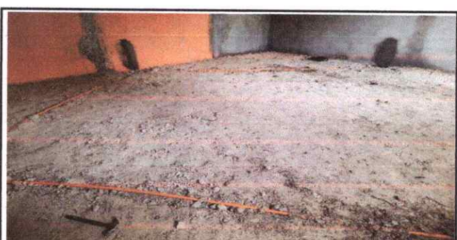
Foto 6: SUSTITUCIÓN DE PISO DE CEMENTO LIQUIDO
