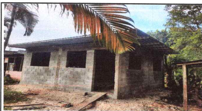
Foto 3: SUSTITUCIÓN DE VENTANAS DE MADERA, POR METAL
