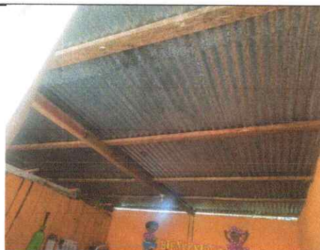
Foto 5: Sustitución de Estructura de soporte de madera, metal
