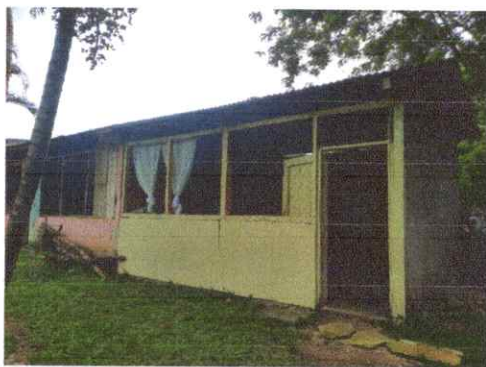
Foto1: Reparación de Repello y Cernido de Paredes
