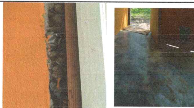
Foto 6: Sellado de grietas y fisuras, Sustución de piso de cemento liquido
