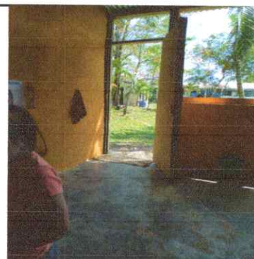
Foto 4: Sustitución de Puerta
