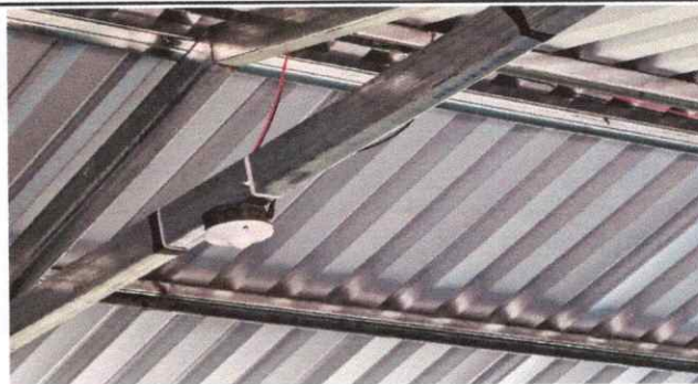
Foto 2 Sustitucion de soporte de madera por metal
