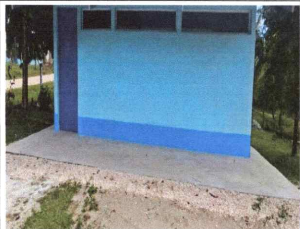
foto: 7 Pintura de muros interiores y exteriores
