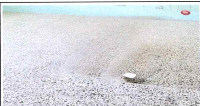
Foto: 5 Sustitucion de cemento liquido por piso de granito
