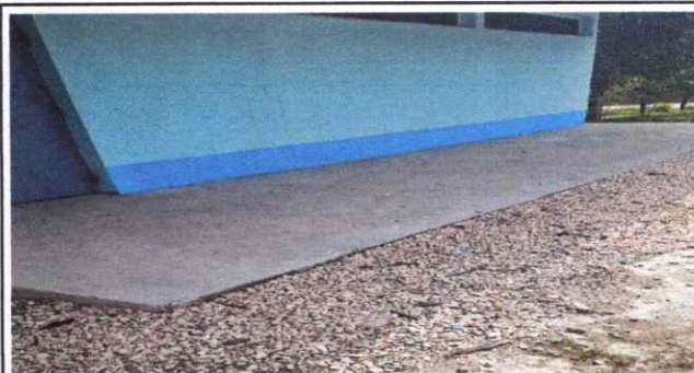
Foto: 6 Reparacion de banqueta de concreto
