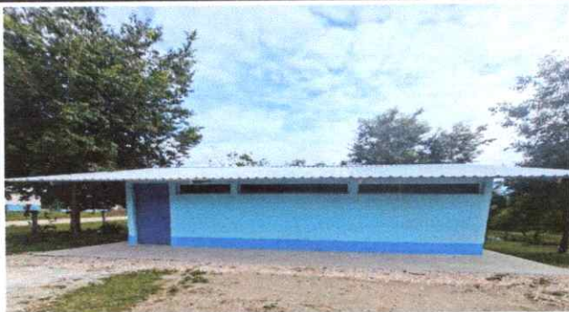
Foto 1: Cambio de cubierta de laminas
