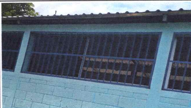
Foto: 4 Sustitucion de malla por balcones
