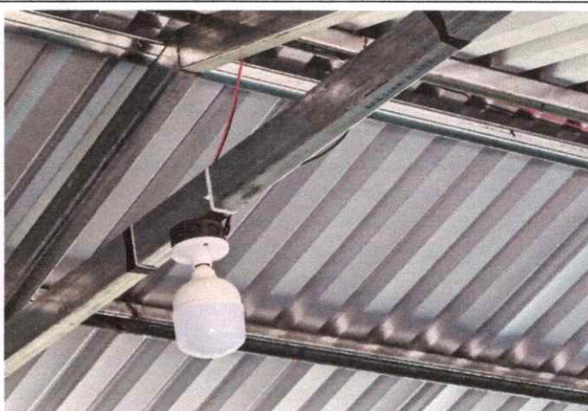
foto: 8 Reparacion del cableado electrico mas accesorios
