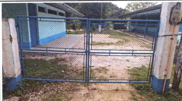
Foto: 3 Sustitucion de porton de metal
