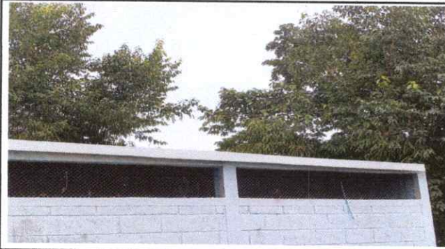
Foto 1: Cambio de cubierta de laminas
