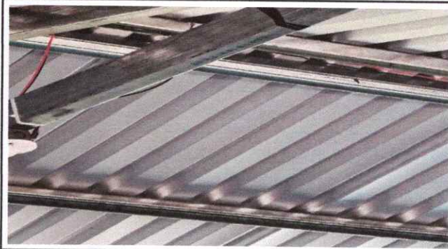
Foto 2 Sustitucion de soporte de madera por metal
