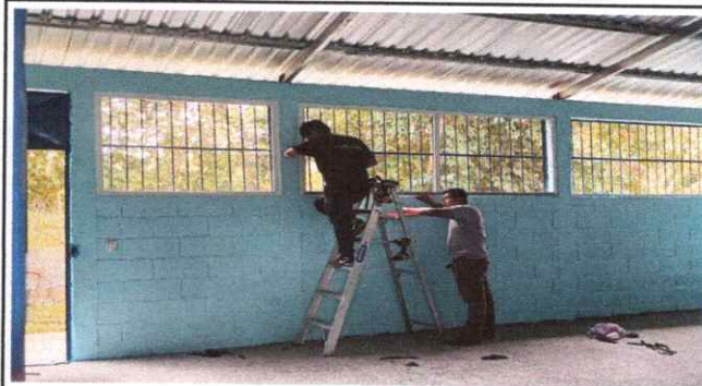
Foto 4 Sustitucion de malla por balcones
