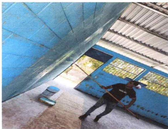
foto: 7 Pintura de muros interiores y exteriores
