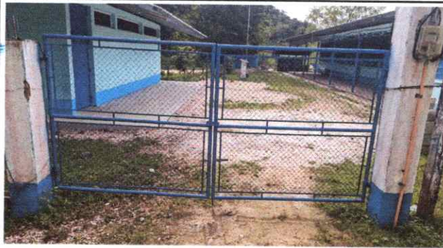
Foto 3 Sustitucion de porton de metal
