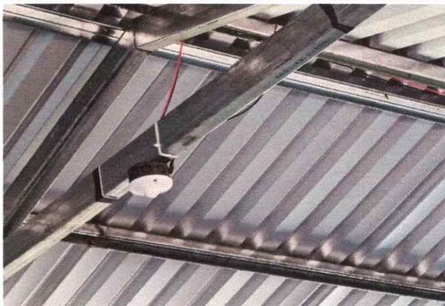
foto: 8 Reparacion del cableado electrico mas accesorios
