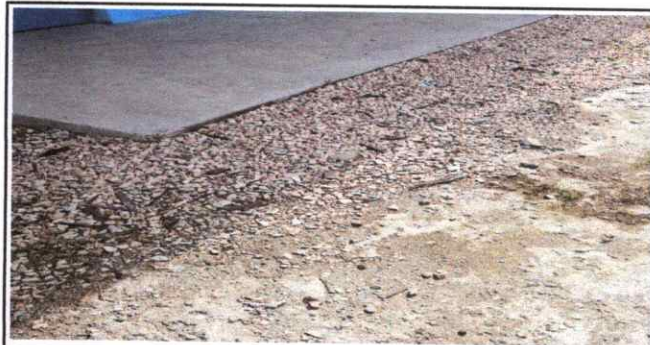
Foto 6 Reparacion de banqueta de concreto
