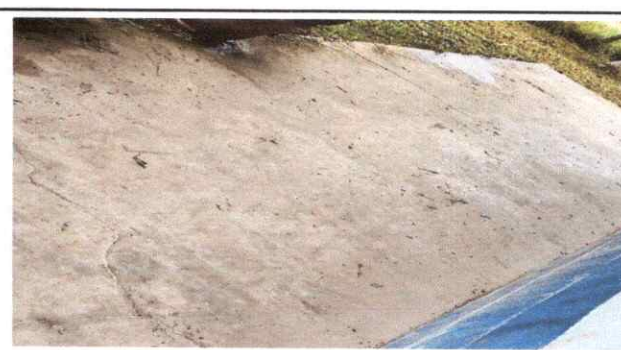
Foto: 6 Reparacion de banqueta de concreto
