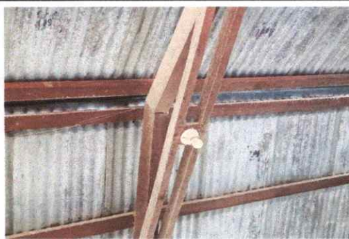
Foto 8: Reparacion del cableado electrico mas accesorios
