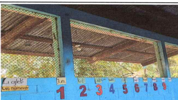
Foto: 4 Sustitucion de malla por balcones
