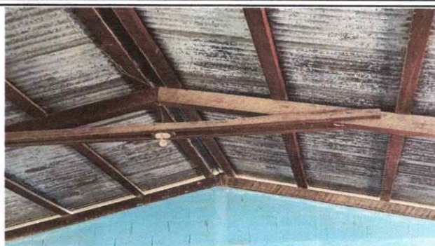
Foto 2 Sustitucion de soporte de madera por metal
