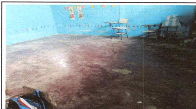
Foto: 5 Sustitucion de cemento liquido por piso de granito
