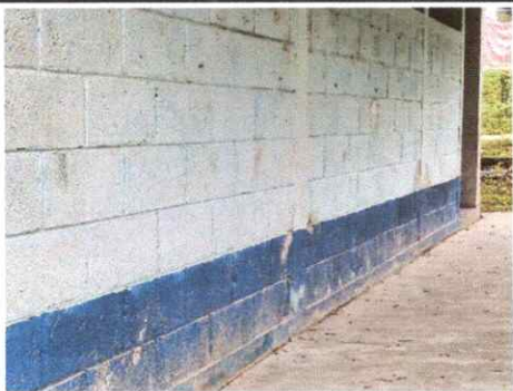
Foto 7: Pintura de muros interiores y exteriores
