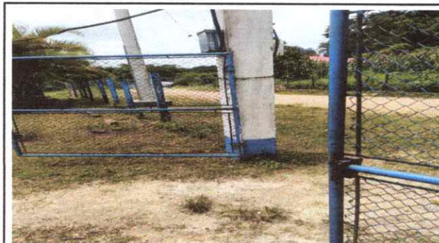
Foto: 3 Sustitucion de porton de metal
