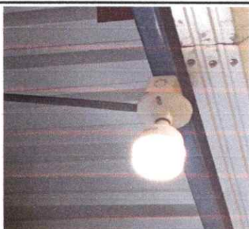
Foto 5: SUSTITUCIÓN DE FOCOS AHORRADORES
