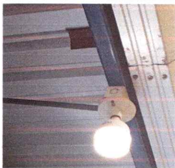
Foto 3: SUSTITUCIÓN DE PLAFONERAS
