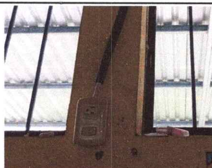
Foto 6: SUSTITUCIÓN DE TOMACORRIENTES
