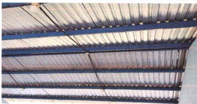
Foto1: SUSTITUCION DE DUCTO ELÉCTRICO + ACCESORIOS
