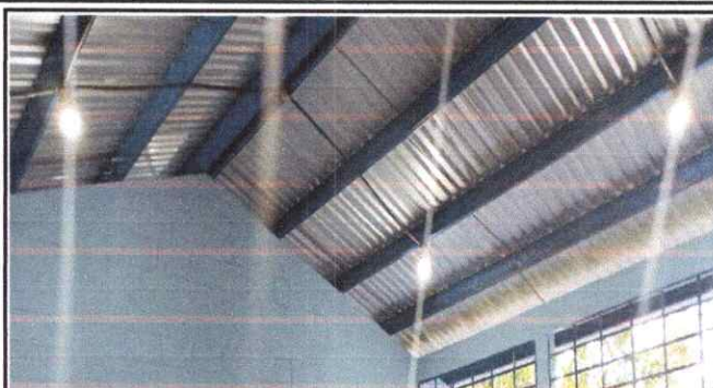
Foto 2: MANTENIMIENTO A ESTRUCTURA DE SOPORTE DE METAL
