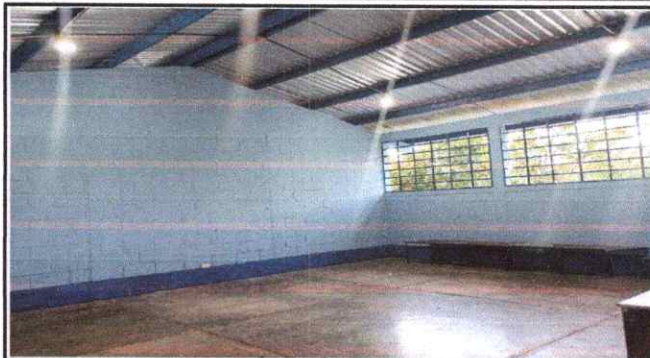
Foto 2: SUSTITUCIÓN DE PINTURA EN MUROS INTERIORES Y EXTERIORES
