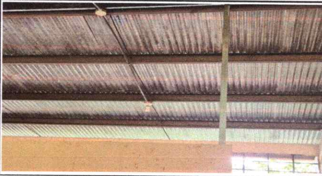
Foto 1: SUSTITUCION DE DUCTO ELÉCTRICO + ACCESORIOS
