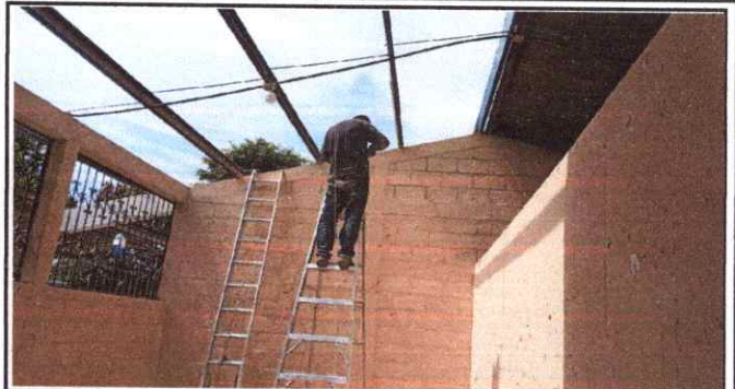
Foto 2: MANTENIMIENTO A ESTRUCTURA DE SOPORTE DE METAL
