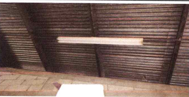
Foto 5: SUSTITUCIÓN DE FOCOS AHORRADORES
