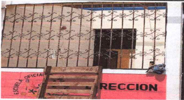
Foto 3: MANTENIMIENTO A BALCONES DE METAL
