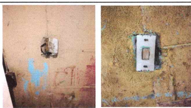
Foto 4: SUSTITUCIÓN DE INTERRUPTORES
