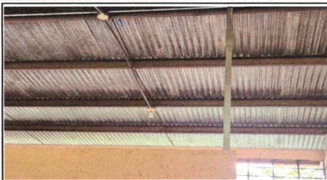
Foto1: SUSTITUCION DE DUCTO ELÉCTRICO + ACCESORIOS
