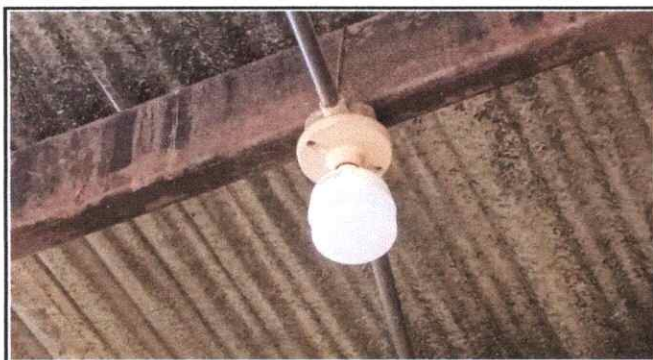
Foto 3: SUSTITUCIÓN DE PLAFONERAS
