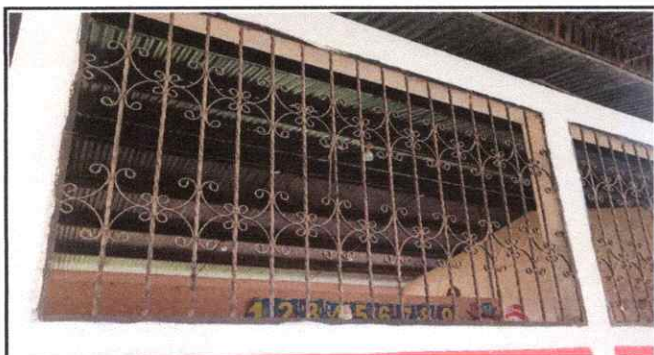
Foto 3: MANTENIMIENTO A BALCONES DE METAL
