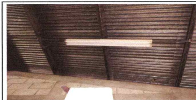
Foto 5: SUSTITUCIÓN DE FOCOS AHORRADORES
