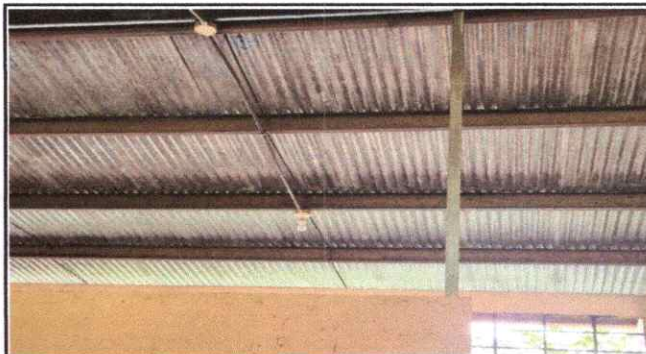
Foto 2: MANTENIMIENTO A ESTRUCTURA DE SOPORTE DE METAL
