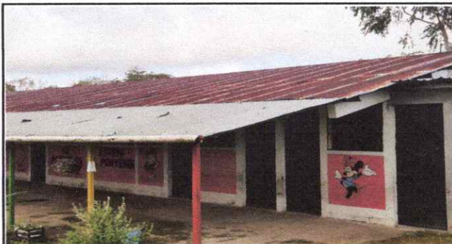
Foto1: SUSTITUCION DE LAMINA POR LAMINA TROQUELADA ALUZINC
