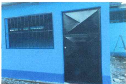
Foto 3: Sustitución de puertas.
