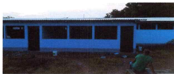
Foto 8: Instalación de lámina troquelada aluzinc.
