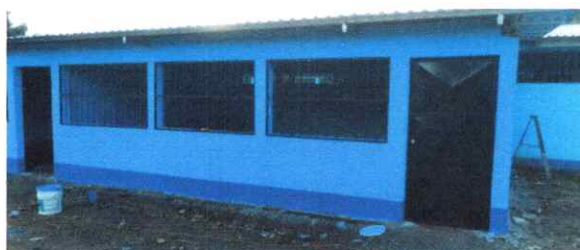
Foto 6: Pintura en muros exteriores e interiores.
