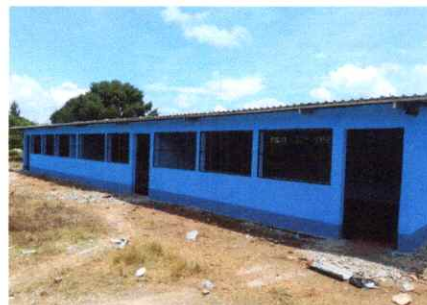
Foto 12: Aplicación de repello en muro.
