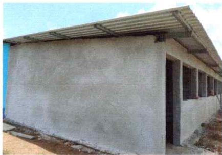
Foto 9: Aplicación de repello en muro.
