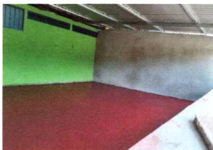
Foto 5: Sustitución de piso de cemento líquido.
