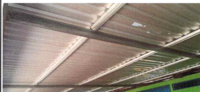
Foto 1: Sustitución de elementos de fijación.
