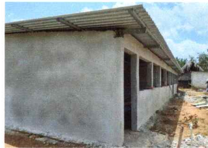
Foto 10: Aplicación de repello en muro.
