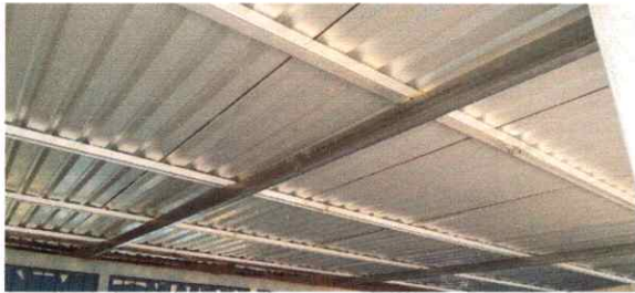
Foto 7: Instalación de estructura portante de metal.
