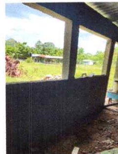
Foto 12: Aplicación de repello en muro.
