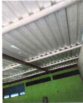
Foto 8: Instalación de lámina troquelada aluzinc.
