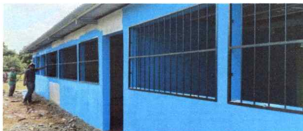
Foto 6: Pintura en muros exteriores e interiores.
