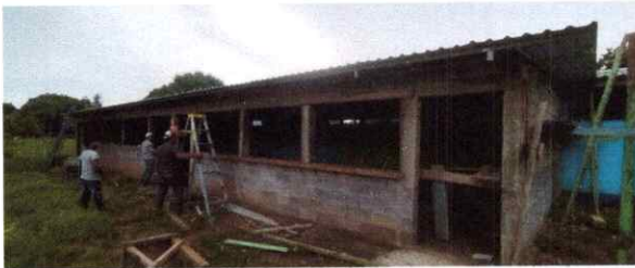
Foto 11: Aplicación de repello en muro.
