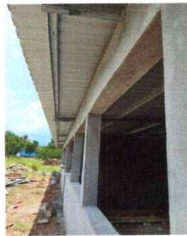
Foto 10: Aplicación de repello en muro.
