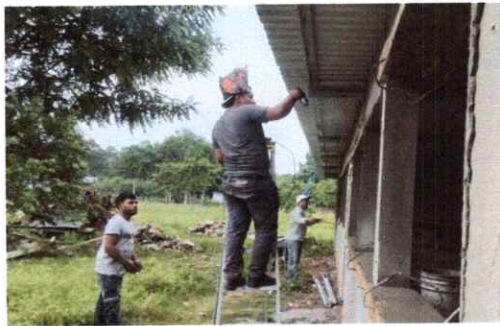
Foto 9: Aplicación de repello en muro.
