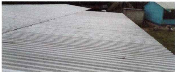
Foto 1: Sustitución de elementos de fijación.
