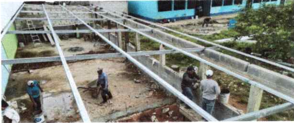
Foto 7: Instalación de estructura portante de metal.
