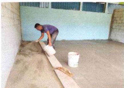
Foto 5: Sustitución de piso de cemento líquido.
