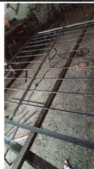
Foto 4: Sustitución de balcones de madera y malla metálica por metal.
