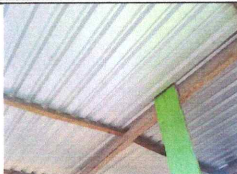
Foto 8: Instalación de lámina troquelada aluzinc.
