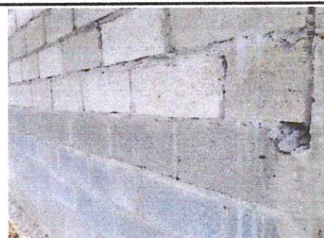
Foto 11: Aplicación de repello en muro.
