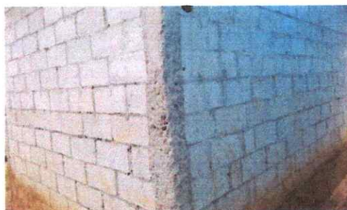
Foto 12: Aplicación de repello en muro.
