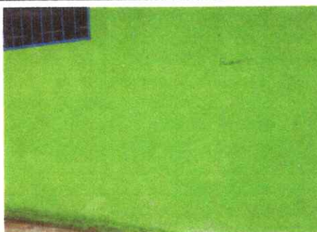
Foto 6: Pintura en muros exteriores e interiores.
