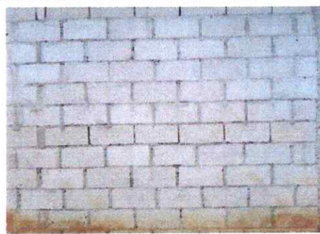
Foto 10: Aplicación de repello en muro.
