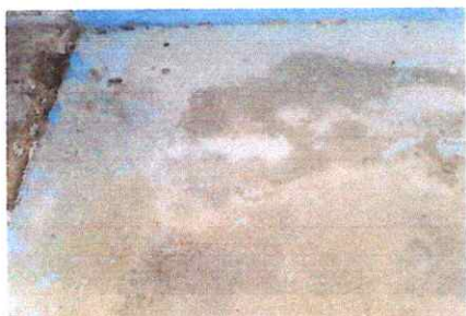
Foto 5: Sustitución de piso de cemento líquido.
