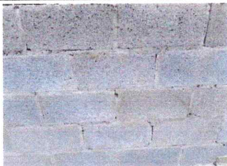
Foto 9: Aplicación de repello en muro.
