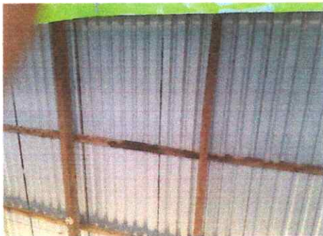
Foto 7: Instalación de estructura portante de metal.
