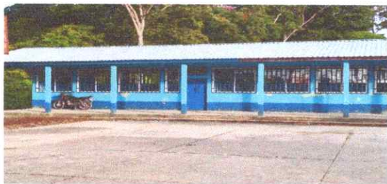
Foto: 1 Fabricación e instalación de Ventanas de PVC.
