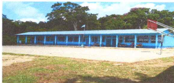
Foto: 2 Fabricación e instalación de Ventanas de PVC.
