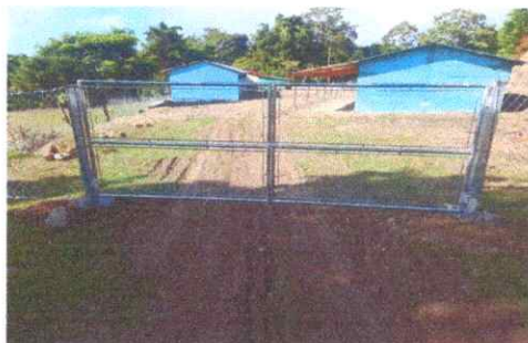
Foto: 9 Fabricación e instalacion de portón de metal de ingreso.
