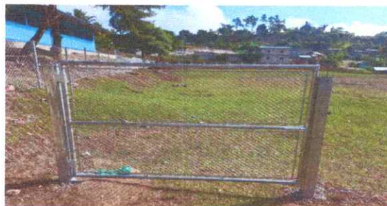
Foto: 10 Fabricación e instalacion de portón de metal de ingreso.
