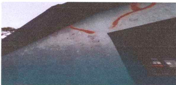
Foto: 5 Sellado de grietas y fisuras en muros.
