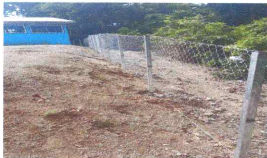
Foto 7: Reparación de tubo hg y malla galvanizada
