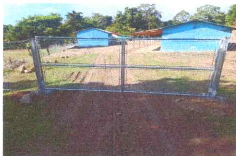
Foto 8: Reparación de tubo hg y malla galvanizada
