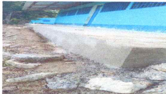
Foto: 4 Sustitución de piso de torta de concreto.
