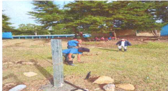
Foto 8: Reparación de tubo hg y malla galvanizada
