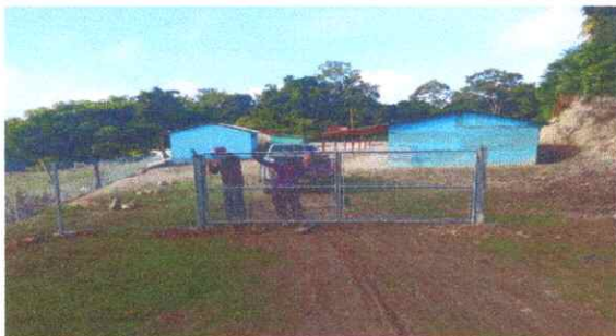
Foto 9: Fabricación e instalacion de portón de metal de ingreso.
