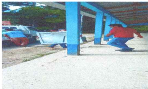
Foto: 1 Fabricación e instalación de Ventanas de PVC.
