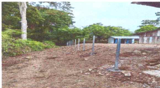
Foto 7: Reparación de tubo hg y malla galvanizada
