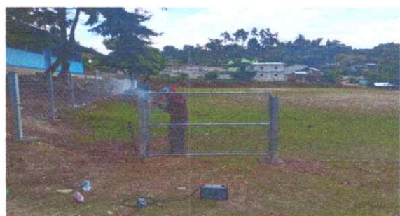
Foto 10: Fabricación e instalacion de portón de metal de ingreso.
