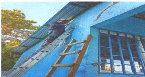
Foto: 5 Sellado de grietas y fisuras en muros.
