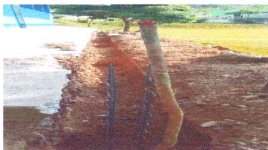
Foto: 3 Sustitución de piso de torta de concreto.
