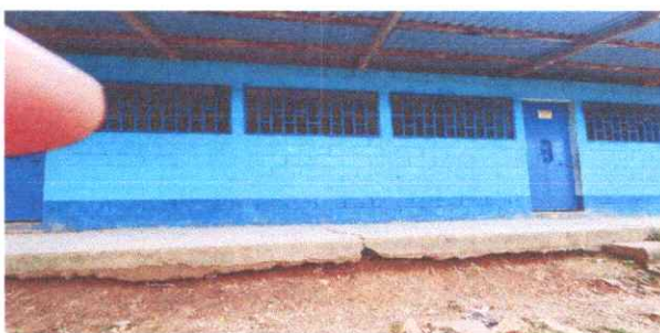
Foto: 4 Sustitución de piso de torta de concreto.
