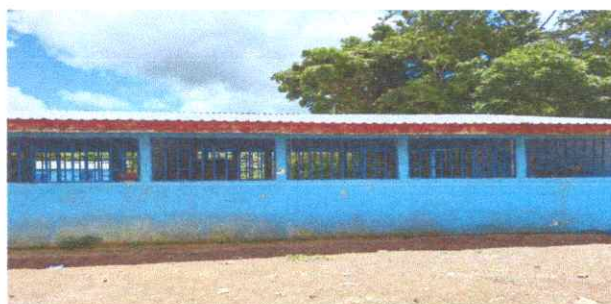
Foto: 2 Fabricación e instalación de Ventanas de PVC.
