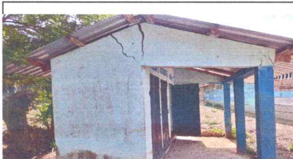
Foto: 6 Sellado de grietas y fisuras en muros.
