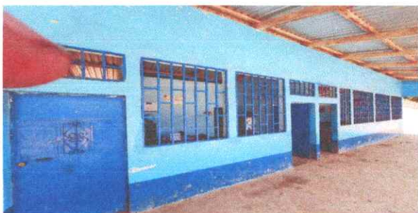
Foto: 1 Fabricación e instalación de Ventanas de PVC.
