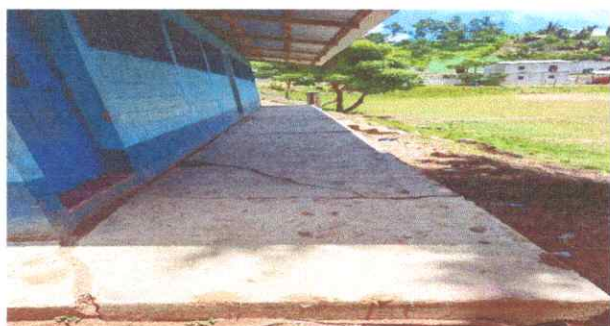
Foto: 3 Sustitución de piso de torta de concreto.
