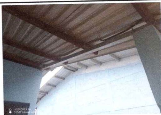
Foto 3: Sustitución de estructura de metal por metal
