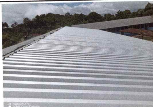
Foto 4: Sustitución de lamina troquelada aluzinc
