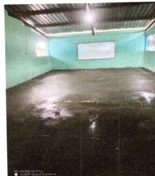
Foto 2: Sustitución de torta de cemento
