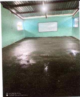
Foto 1: Sustitución de torta de cemento
