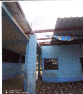
Foto 3: Sustitución de estructura de metal por metal
