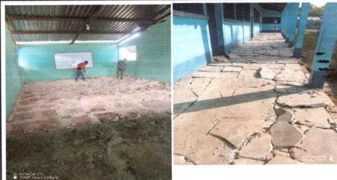
Foto 2: Sustitución de torta de cemento
