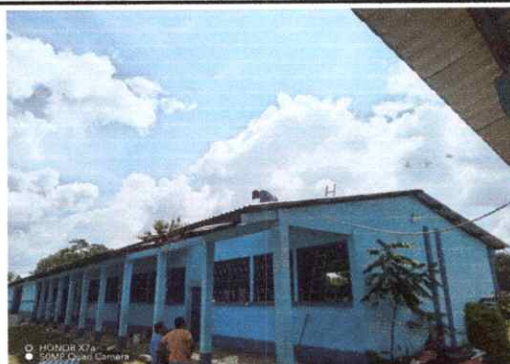
Foto 4: Sustitución de lamina troquelada aluzinc
