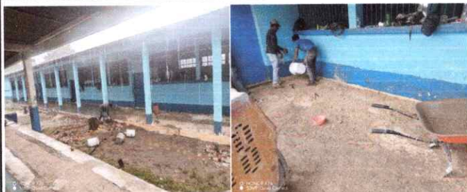
Foto1: Sustitución de torta de cemento
