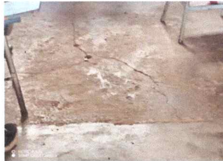
Foto 4 SUSTITUCION DE PISO DE TORTA DE CONCRETO
