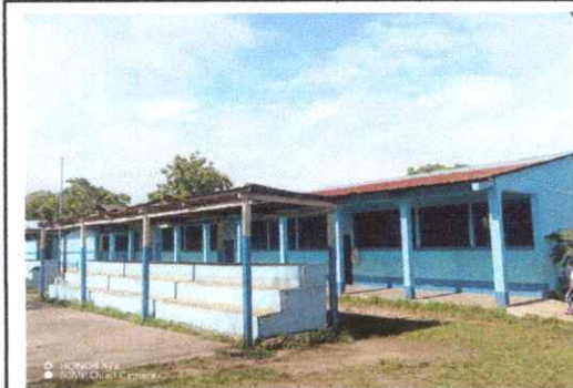
Foto 1: SUSTITUCIÓN DE LÁMINA, POR LAMINA TROQUELADA ALUZINC CALIBRE 26
