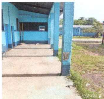
Foto 5 SUSTITUCION DE PISO DE TORTA DE CONCRETO
