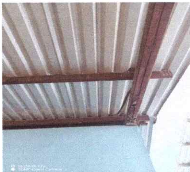
Foto 3: SUSTITUCIÓN DE ESTRUCTURA DE METAL POR METAL
