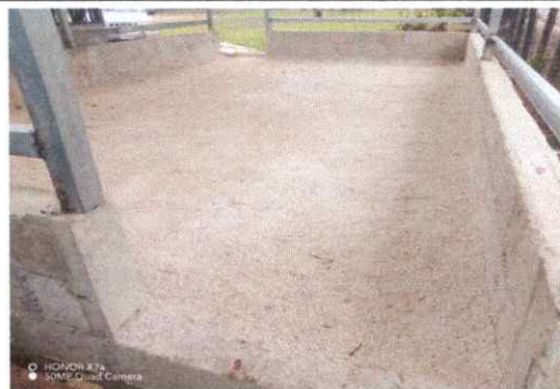
Foto 2 SUSTITUCIÓN DE PISO DE TIERRA POR PISO DE TORTA DE CONCRETO
