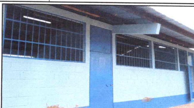
Foto 2: Mantenimiento a estructura, puerta metálica
