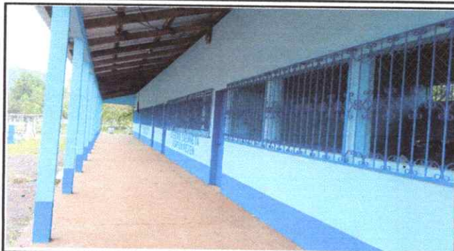
Foto1: Pintura en muros, exteriores e interiores
