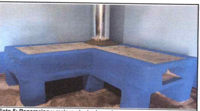
Foto 5: Reparacion y mejoramiento de cocina
