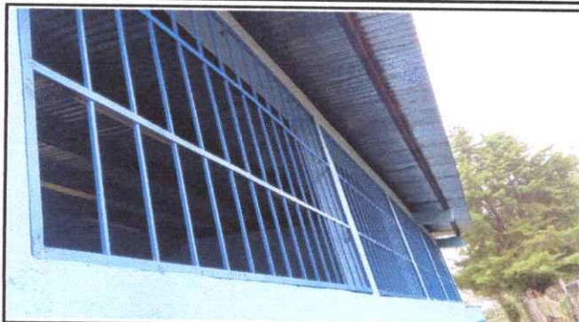
Foto1: Sustitución de ventanas, por balcones metalicos
