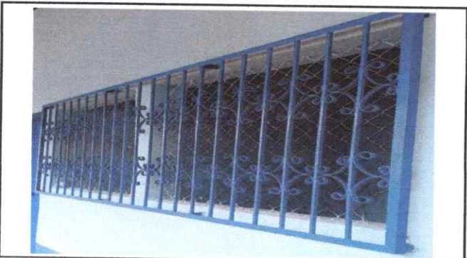
Foto 3: Reparacion y mantenimiento de balcones
