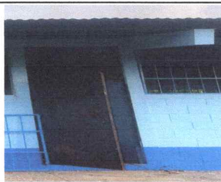
Foto 2: Mantenimiento a estructura, puerta metálica
