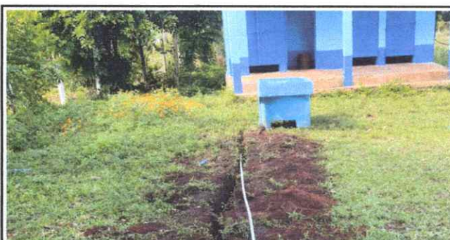
Foto 6: Sustitución de pila
