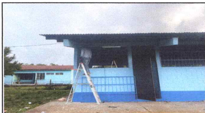
Foto 3: Reparación y mantenimiento de balcones
