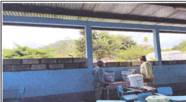
Foto1: Sustitución de ventanas, por balcones metalicos
