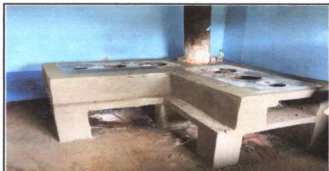
Foto 5: Reparación y mejoramiento de cocina
