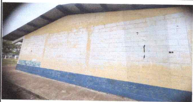
Foto 1: Pintura en muros, exteriores e interiores
