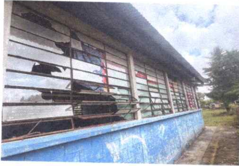
Foto1: Sustitución de ventanas, por balcones metalicos
