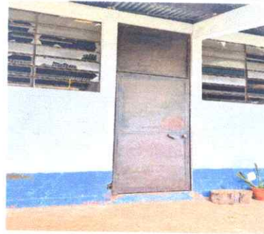
Foto 2: Mantenimiento a estructura, puerta metálica
