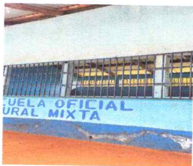
Foto 3: Reparación y mantenimiento de balcones
