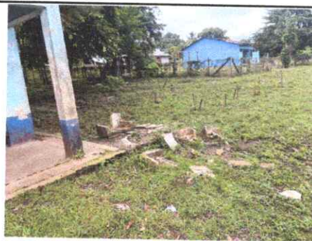
Foto 6: Sustitución de pila
