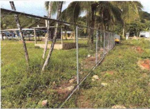
Foto: 3 FINALIZACIÓN DE INSTALACIÓN DE TUBO HG Y MALLA GALVANIZADA
