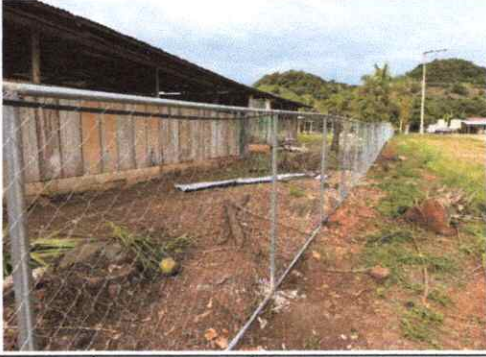
Foto: 4 FINALIZACIÓN DE INSTALACIÓN DE TUBO HG Y MALLA GALVANIZADA
