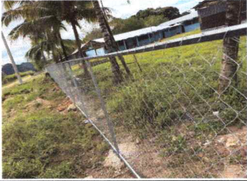
Foto 2 FINALIZACIÓN DE INSTALACIÓN DE TUBO HG Y MALLA GALVANIZADA
