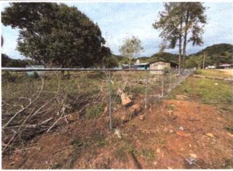
Foto: 5 FINALIZACIÓN DE INSTALACIÓN DE TUBO HG Y MALLA GALVANIZADA
