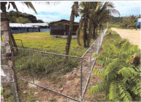
Foto 1: FINALIZACIÓN DE INSTALACIÓN DE TUBO HG Y MALLA GALVANIZADA
