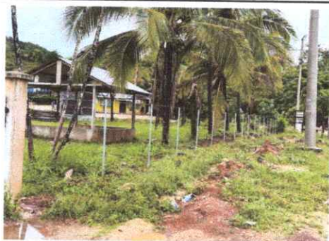
Foto 5: COLOCACIÓN DE TUBO HG Y MALLA GALVANIZADA
