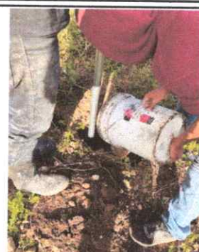
Foto 2: COLOCACIÓN DE TUBO HG Y MALLA GALVANIZADA
