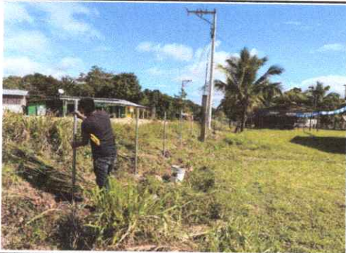
Foto 3: COLOCACIÓN DE TUBO HG Y MALLA GALVANIZADA
