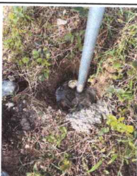
Foto 4: COLOCACIÓN DE TUBO HG Y MALLA GALVANIZADA
