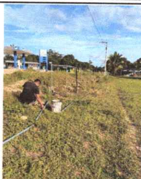
Foto 2: COLOCACIÓN DE TUBO HG Y MALLA GALVANIZADA
