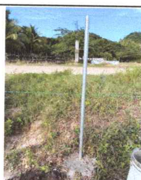
Foto 4: COLOCACIÓN DE TUBO HG Y MALLA GALVANIZADA
