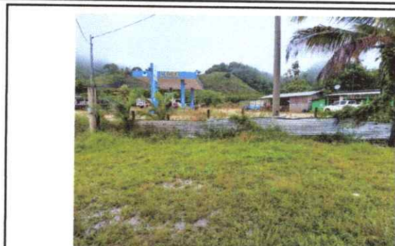
Foto 2: DESINSTALACIÓN DE POSTES DE CHICO Y ALAMBRE DE PÚAS.
