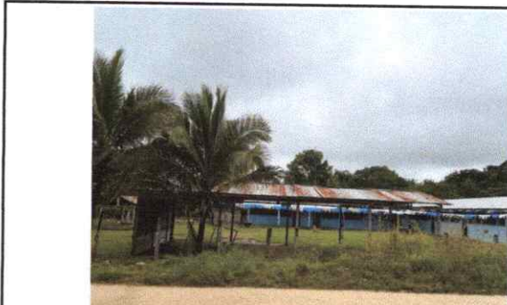
Foto 4: DESINSTALACIÓN DE POSTES DE CHICO Y ALAMBRE DE PÚAS.
