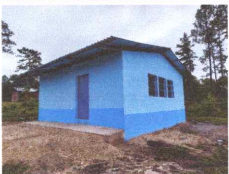
Foto 3:Reforzamiento de columnas y soleras
