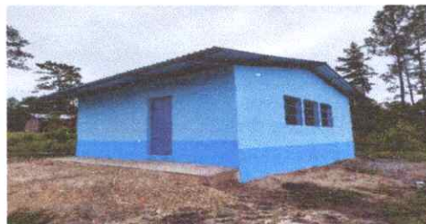
Foto: 6 Sustitución de puerta
