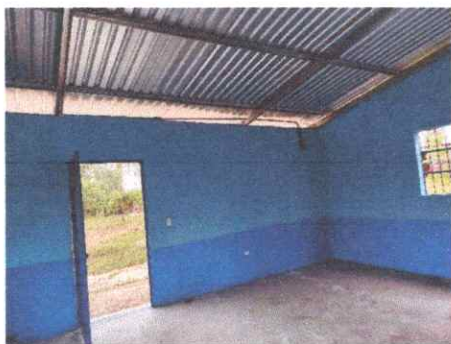
Foto 1: Reparación de cableado eléctrico
