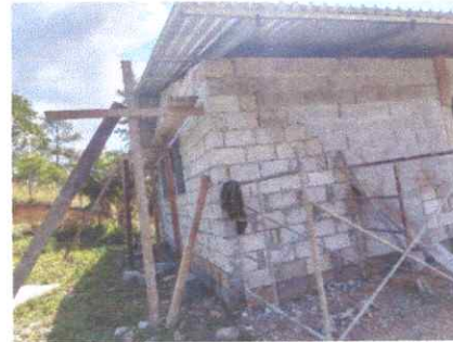
Foto 4: Sustitución de lámina, por lámina troquelada aluzinc calibre 26
