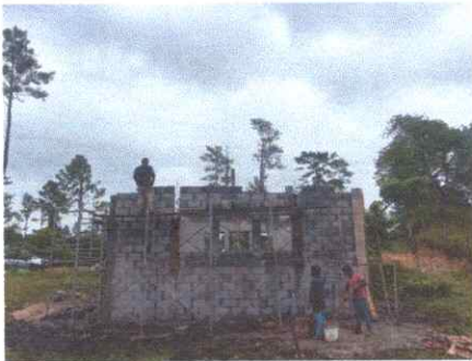
Foto 3: Reforzamiento de columnas y soleras
