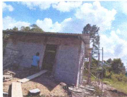
Foto 6: Sustitución de puerta
