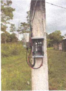
Foto 1: Reparación de cableado eléctrico
