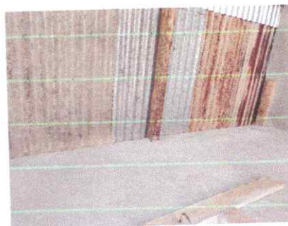
Foto: 4 Sustitución de lámina, por lámina troquelada aluzinc calibre 26
