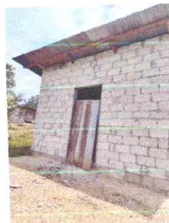
Foto: 6 Sustitución de puerta
