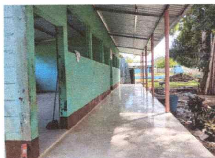
Foto 6: Sustrucion de piso por piso ceramico
