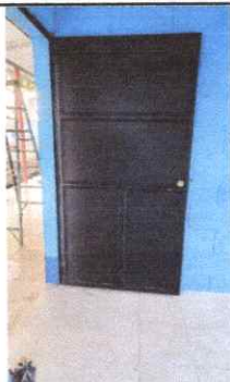
Foto 3: Mantenimineto a estructura
