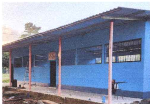
Foto 1: Pintura en muros exterior e interior
