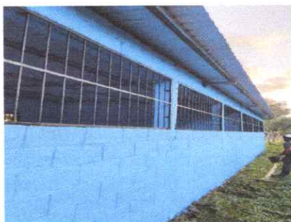
Foto: 5 Sustrución de balco de madera y malla metalica por metal
