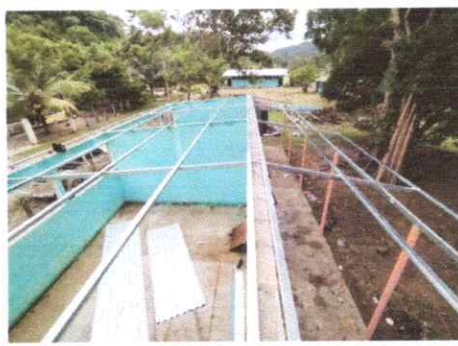
Foto: 2 Sustrución de estructura de soporte de madera por metal
