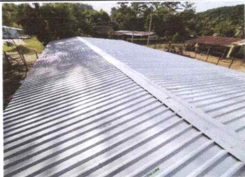
Foto 1: Sustrución de cubierta de techo.
