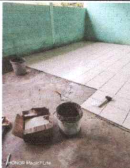
Foto 6: Sustitución de piso por piso cerámico
