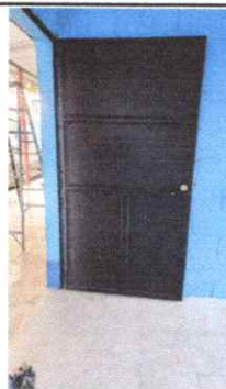
Foto: 4 Sustitución de chapas
