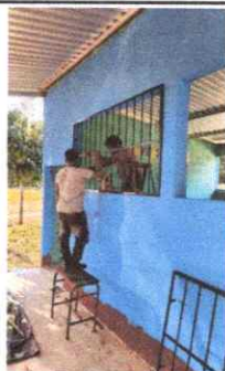
Foto: 5 Sustitución de balco de madera y malla metálica por metal
