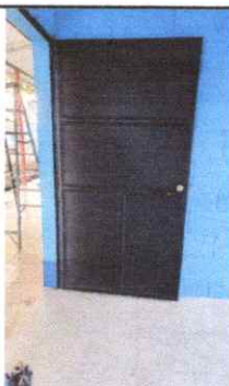
Foto 3: Mantenimiento a estructura
