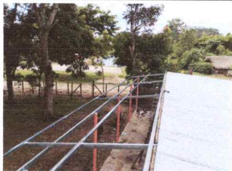
Foto 1: Sustitución de cubierta de techo.
