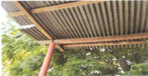
Foto 1: Sustrucción de cubierta de techo
