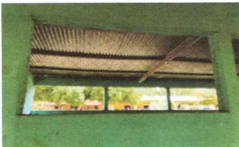
Foto 5: Sustrucción de balco de madera y malla metálica por metal
