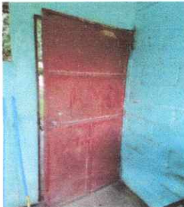
Foto 3: Mantenimiento a estructura
