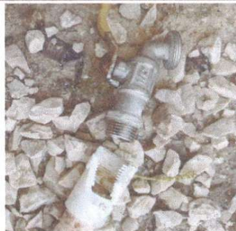
Foto 4: Sustitución de llave de Chorro.
