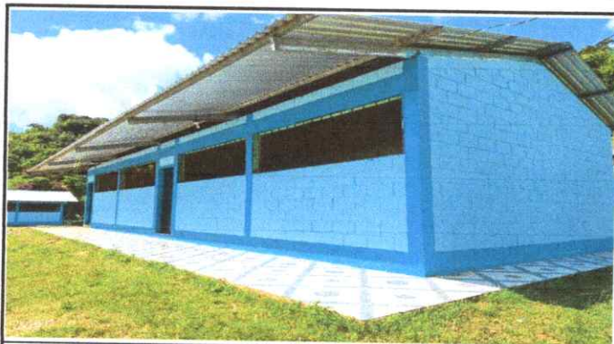
Foto 3: Pintura en muros exteriores e interiores
