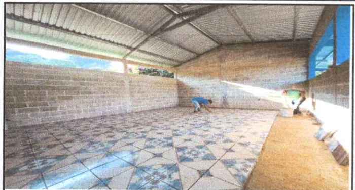
Foto 2: Sustitución de torta de concreto por piso cerámico
