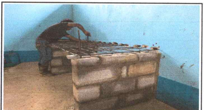
Foto 4: Fabricación de mueble de cocina
