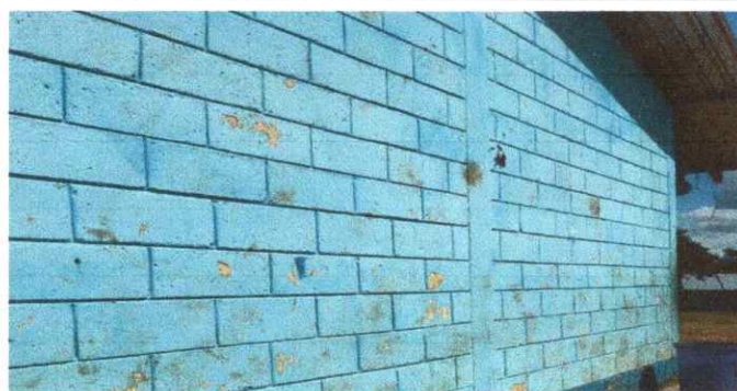
Foto 3: Pintura en muros exteriores e interiores
