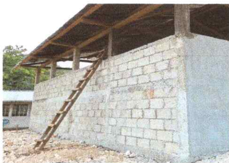
Foto 5: Repello en muro y cernido en muro
