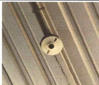
Foto 6: Sustrución de lámparas
