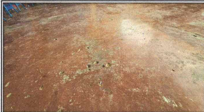
Foto 2: Sustrución de torta de concreto por piso cerámico
