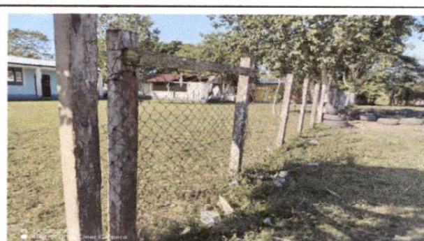
Foto 4: REPARACION DE MALLA GALVANIZADA
