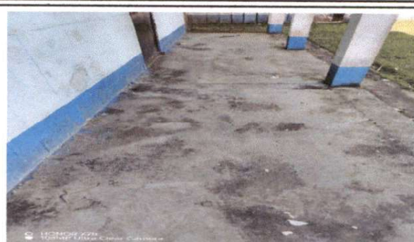
Foto 2: SUSTITUCION DE PISO DE CEMENTO LIQUIDO
