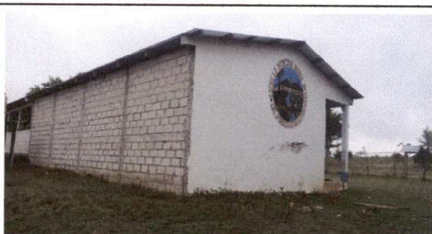
Foto 6: REPELLO EN MURO
