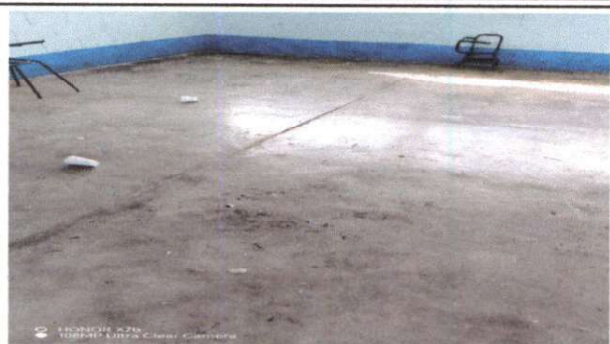
Foto 1: SUSTITUCION DE PISO DE CEMENTO LIQUIDO
