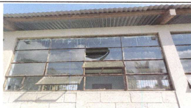
Foto 3: SUSTITUCION DE ESTRUCTURA DE METAL DE VENTANA MAS VIDRIO
