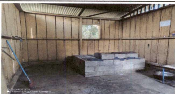
Foto 5: SUSTITUCION DE ESTUFA RURAL (COMPLETA) INCLUYE CHIMENEA Y PLANCHA DE METAL
