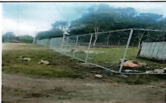
Foto 3: REPARACION DE TUBO HG Y MALLA GALVANIZADA
