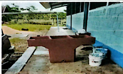
Foto 6: SUSTITUCION DE PILA DE CEMENTO DE DOS LAVADEROS
