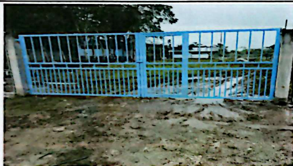
Foto 1: SUSTITUCION DE PORTON
