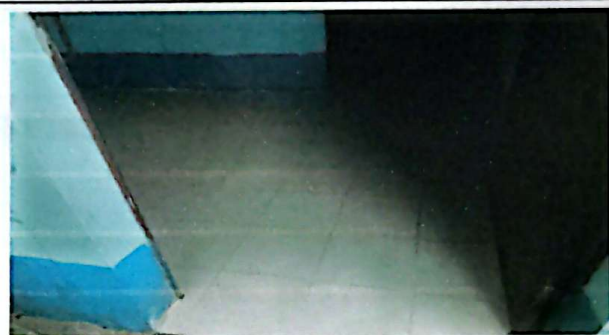
Foto 2: MEJORAMIENTO DE PISO DE CEMENTO LIQUIDO POR PISO CERAMICO
