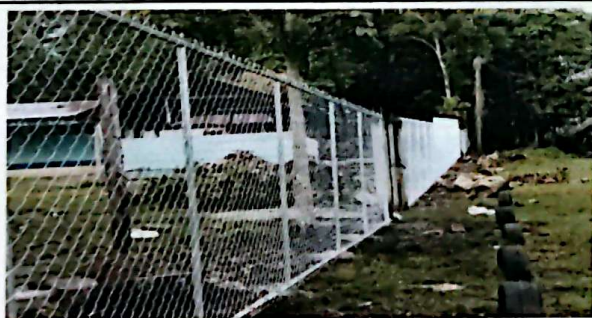
Foto 5: REPARACION DE TUBO HG Y MALLA GALVANIZADA
