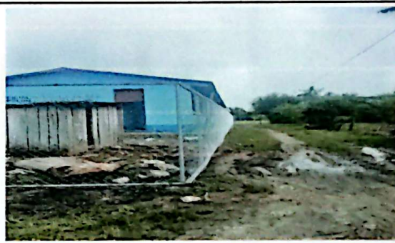
Foto 4: REPARACION DE TUBO HG Y MALLA GALVANIZADA
