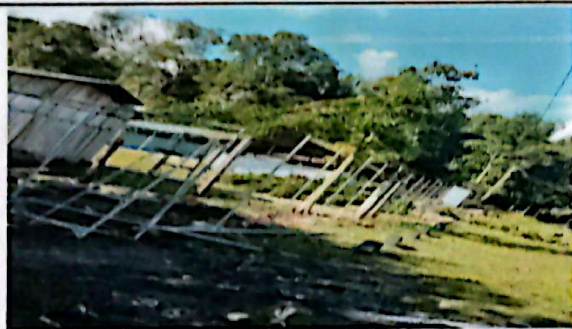
Foto 3: REPARACION DE TUBO HG Y MALLA GALVANIZADA
