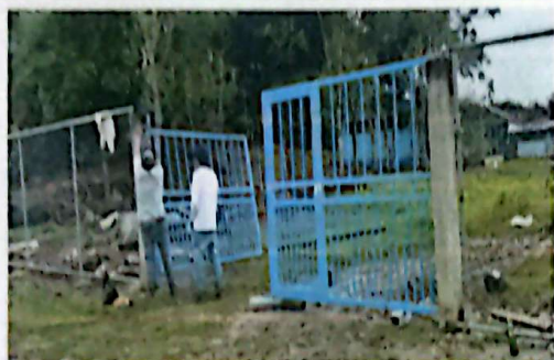
Foto 1: SUSTITUCION DE PORTON
