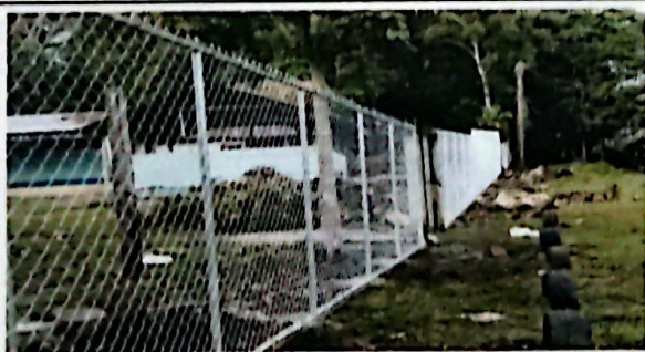
Foto 5: REPARACION DE TUBO HG Y MALLA GALVANIZADA
