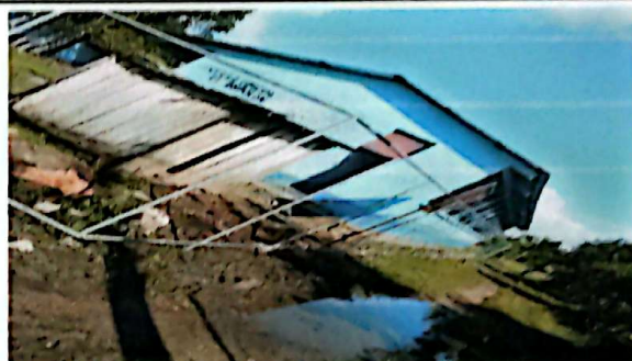
Foto 4: REPARACION DE TUBO HG Y MALLA GALVANIZADA
