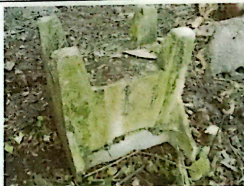
Foto 4: Sustrución de pila de cemento de dos lavadero
