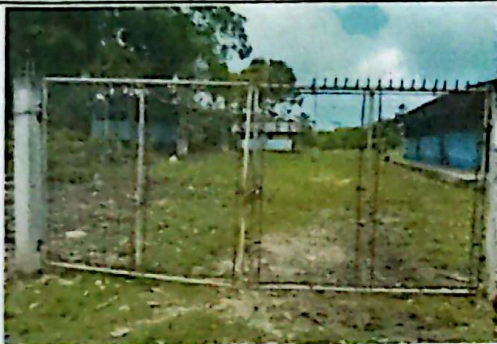
Foto 1: Sustrución de portón de metal
