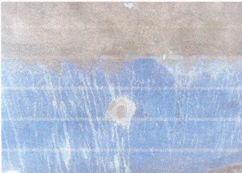
Foto 2: REPARACION DE MURO DE CONTENCIÓN
