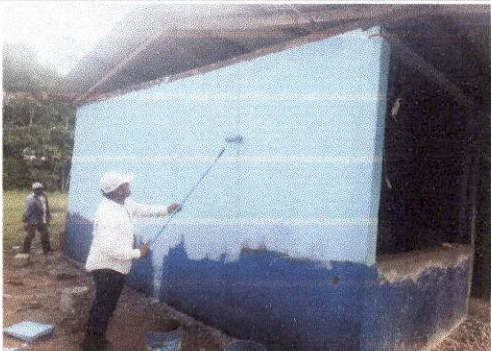
Foto 3: PINTURA EN MUROS EXTERIORES E INTERIORES
