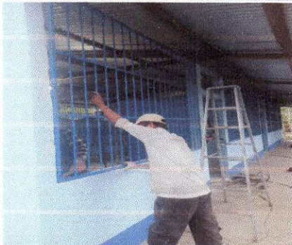
Foto 2: SUSTITUCION DE BALCONES DE METAL
