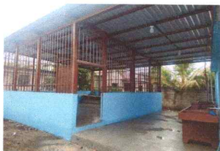
Foto: 5 Pintura en muros exteriores e interiores
