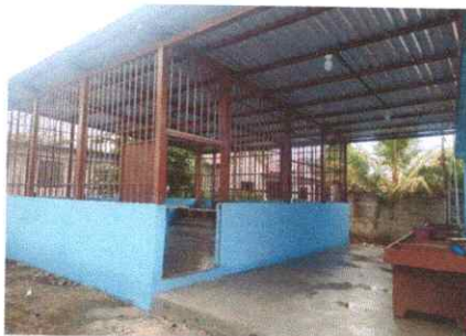
Foto 9: Reparación de repello y Cernido de paredes
