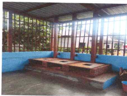
Foto 8: Sustitución de estufa rural (completa) incluy chimenea y plancha de metal
