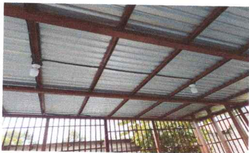
Foto 7: Reparación de sistema eléctrico
