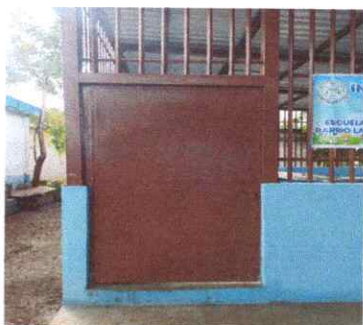
Foto 3 Sustitución de Puerta
