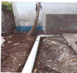
Foto 11: Sustitución de tubería PVC línea principal aguas negras (3pulg o 4 pulg)
