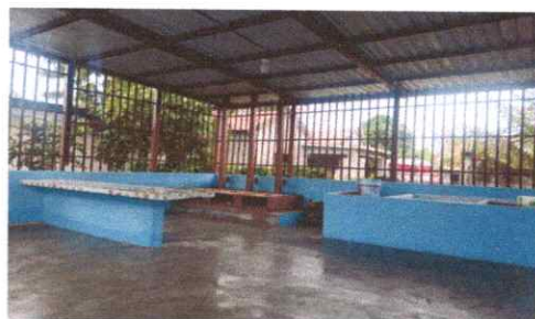
Foto: 4 Sustitución de piso de cemento líquido
