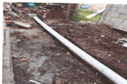
Foto 12: Sustitución de tubería PVC línea principal aguas negras (3 pulg o 4 pulg)
