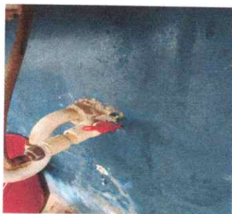
Foto 11: Sustitución de llave de paso
