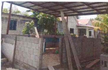
Foto 5: Pintura en muros exteriores e interiores
