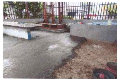
Foto 4: Sustrucción de piso de cemento líquido
