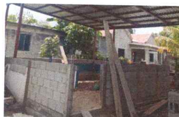
Foto 10: Reparación de repello y Cernido de paredes
