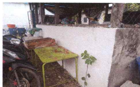
Foto 10: Reparación de repello y Cernido de paredes
