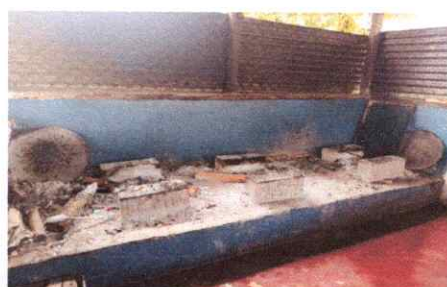
Foto 8: Sustitución de estufa rural (completa) incluy chimenea y plancha de metal
