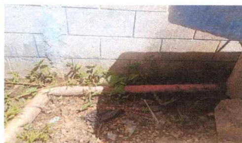
Foto 12: Sustitución de tubería PVC línea principal aguas negras (3pulg o 4 pulg)
