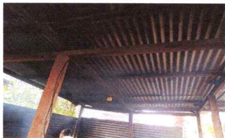
Foto 7: Reparación de sistema eléctrico
