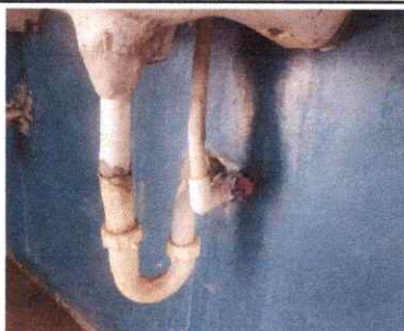
Foto 11: Sustitución de llave de paso
