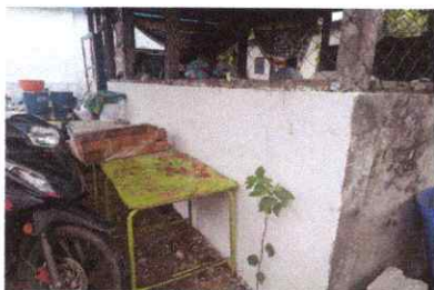
Foto 5: Pintura en muros exteriores e interiores
