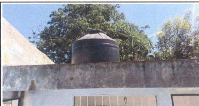
Foto 5: SUSTITUCION DE DEPOSITO DE AGUA
