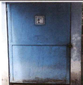
Foto 4: SUSTITUCION DE PUERTAS DE METAL
