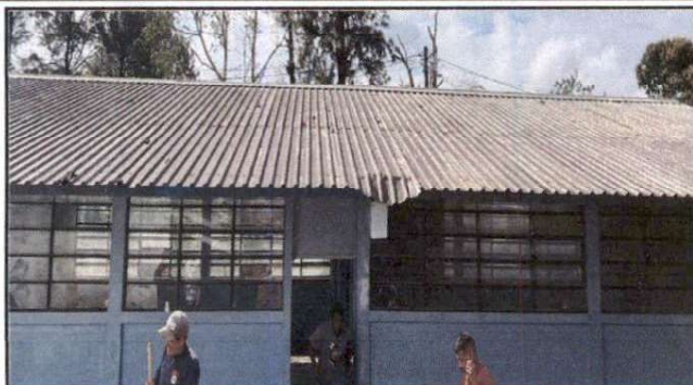
Foto1: SUSTITUCION DE LAMINA POR LAMINA TROQUELADA ALUZINC
