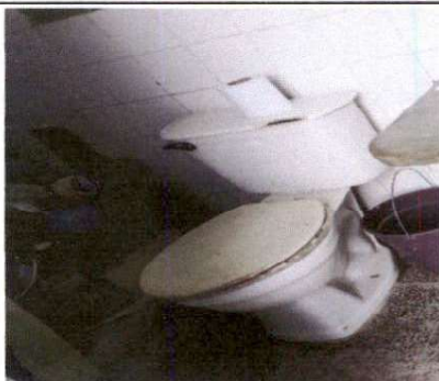
Foto 3: SUSTITUCION DE INODOROS
