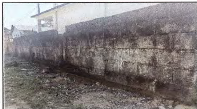
Foto 3. Reparación de muro perimetral de block
