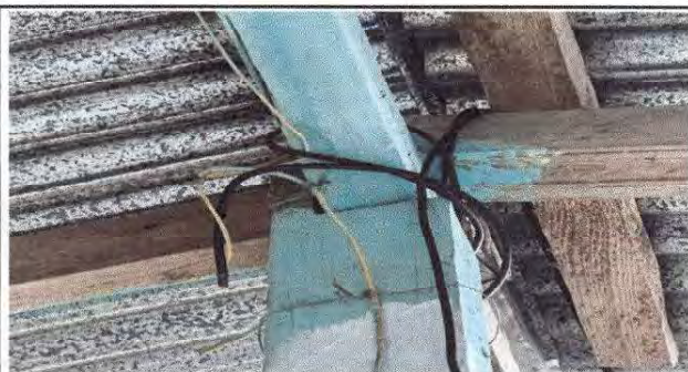
Foto 5. Reparación de cableado eléctrico
