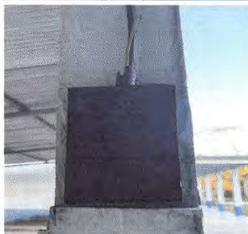
Foto 3. Sustitución de flipones
