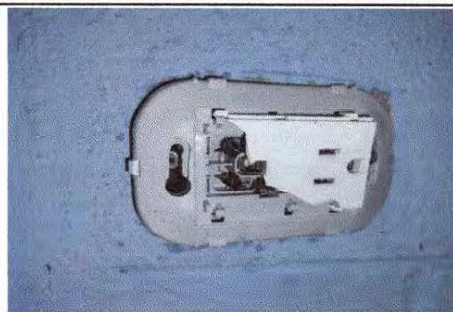
Foto 2. Sustitución de tomacorrientes dobles
