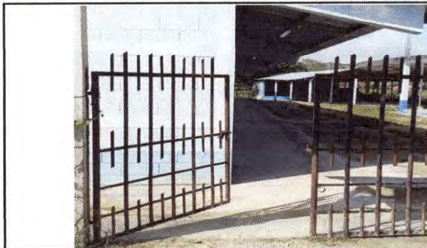
Foto 2. Mantenimiento a porton de metal
