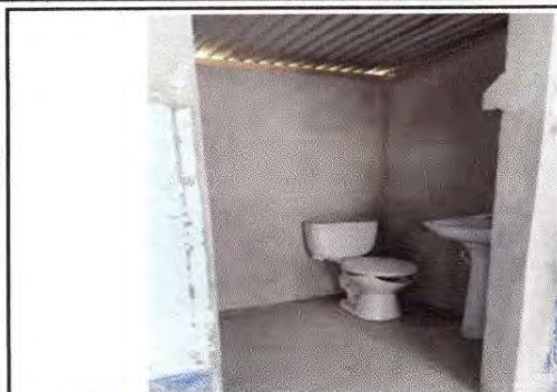
Foto 1. Sustitución de inodoro
