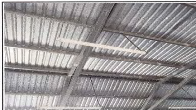
Foto 4. Sustitución de lámparas tipo led
