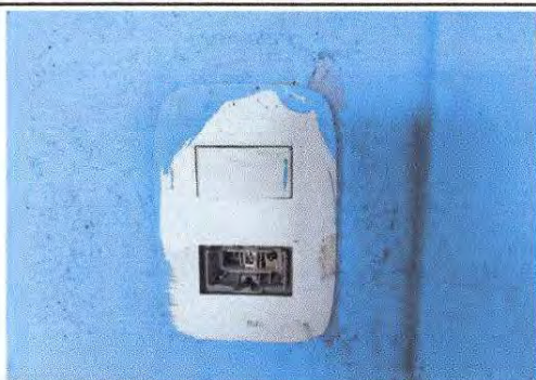
Foto 1. Sustitución de interruptores dobles
