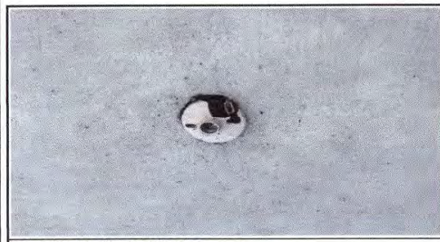
Foto 5. Sustitución de plafoneras
