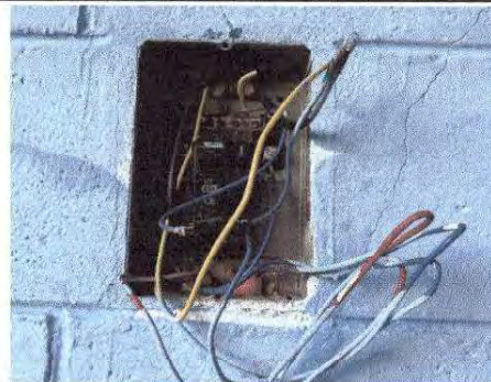
Foto 4. Sustitución de tablero de flipones
