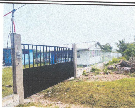
Foto 2: Reparación de tubo hg y malla galvanizada
