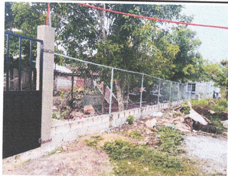
Foto 1: Reparación de tubo hg y malla galvanizada
